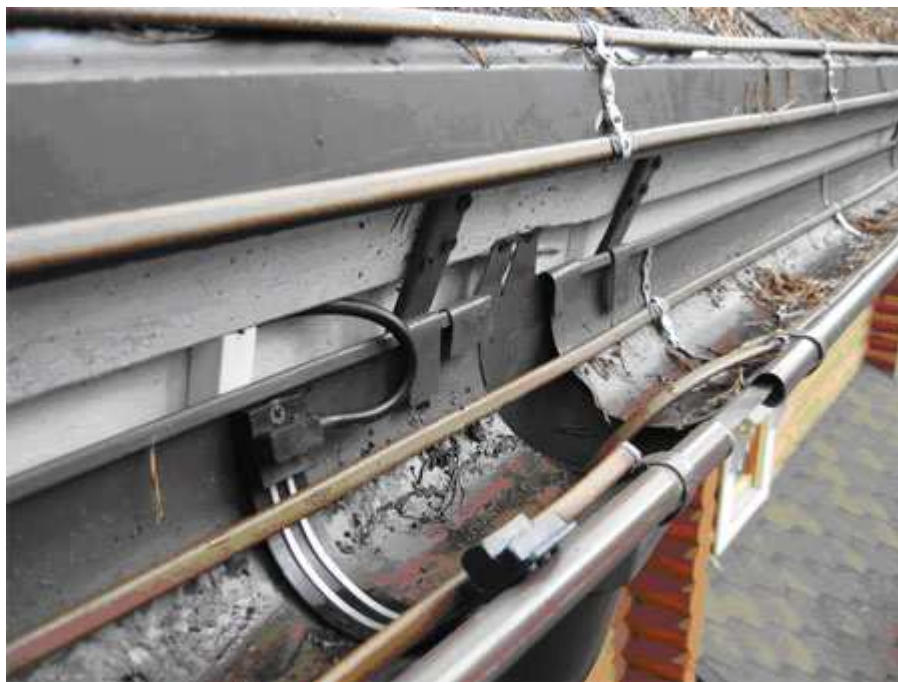
Датчик талой воды, установленный в желобе
